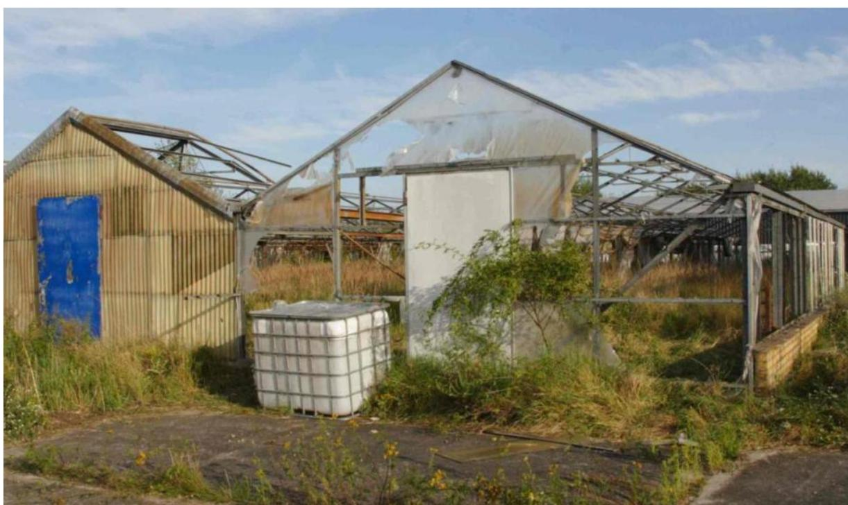
3b) Die selbe Giebelansicht nach Beendigung der Arbeit. Aus dem Giebel wurden nur wenige Streben entfernt. Der Abbau der beiden dargestellten Giebel soll folgen.
