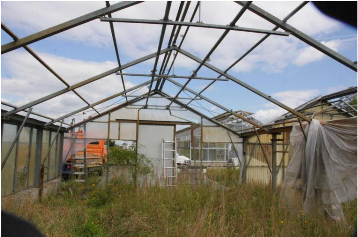
4a) Ansicht vor Beginn der Arbeit. Abgebaut werden sollten die Verstreibungen von Dach, Giebel und Seitenteilen der ersten zwei Segmente auf einer Länge von ca. 6 Metern.
