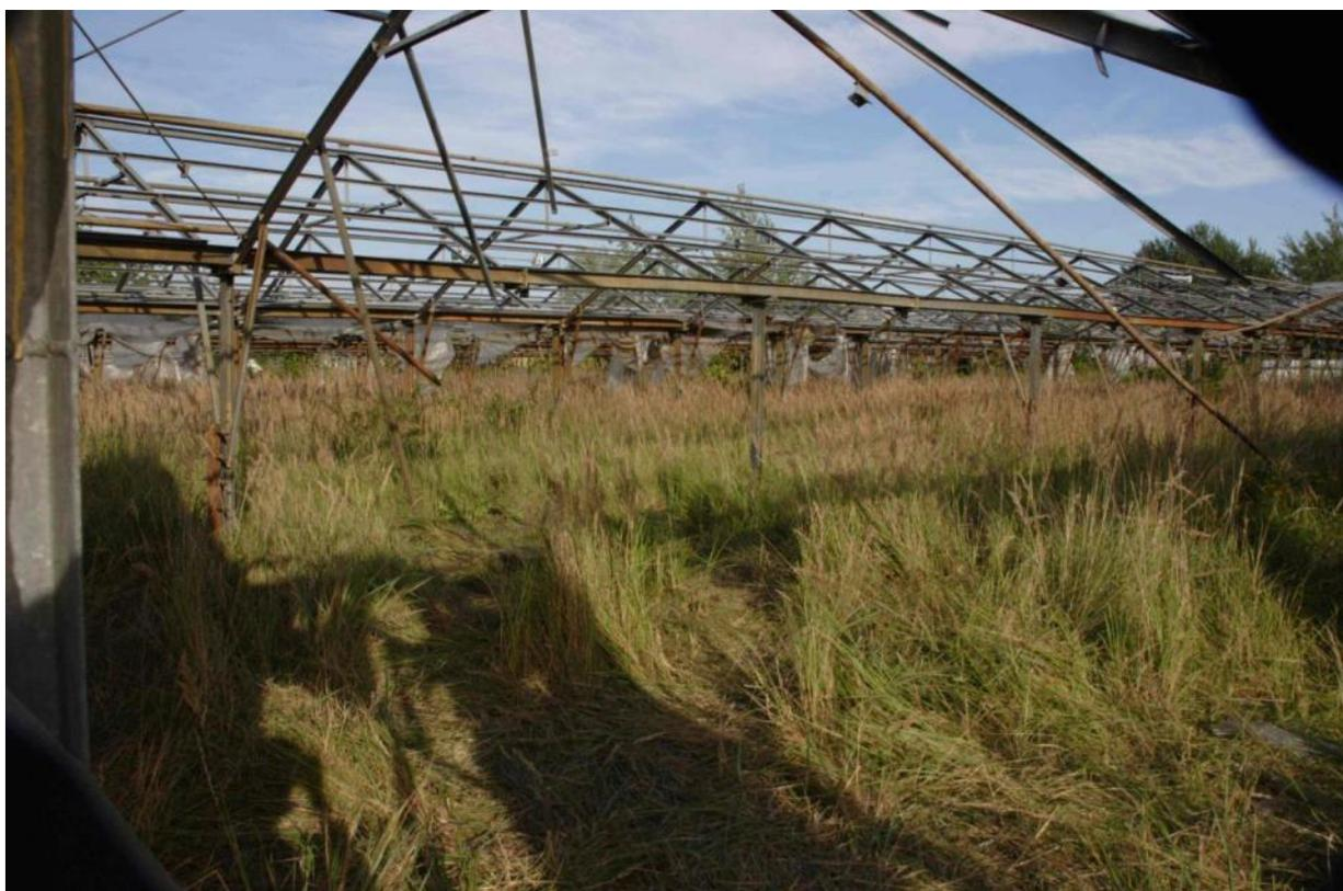
5b) Dokumentation der zwei fehlenden senkrechten Seitenständer des zweiten Segments (in Verlängerung der Dachstreben).
